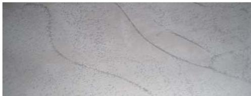
Die erhabenen Stellen (Kanten, Wülste usw.) zeichnen sich nun dunkel ab. In den etwas vertieften Bereichen der Fläche bleibt die hellere Mischung des 2. Auftrages stehen. So entsteht die typische Textur.
