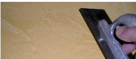
Die erhabenen Stellen (Kanten, Wülste usw.) zeichnen sich nun ab. In den etwas vertieften Bereichen der Fläche bleibt die Mischung des 2. Auftrages stehen. So entsteht die typische Textur.
