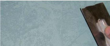
Die erhabenen Stellen (Kanten, Wülste usw.) zeichnen sich nun dunkel ab. In den etwas vertieften Bereichen der Fläche bleibt die hellere Mischung des 2. Auftrages stehen. So entsteht die typische Textur.
