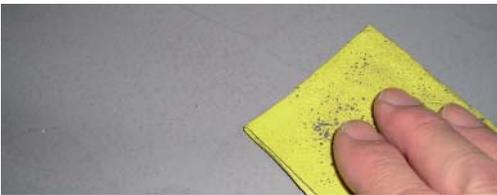
Die im nassen Zustand noch stark auffälligen Kanten und Wülste sind nach der Trocknung (ca. 24 - 48 Std.) beiegefallen und deutlich kleiner. Beim Zwischenschliff mit ca. 150er Schleifpapier werden zu stark erhabene Kanten leicht geglättet, jedoch nicht weggeschliffen.
