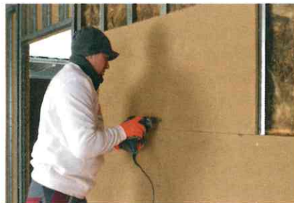
Lehm erfreut sich als natürlicher Baustoff wieder wachsender Beliebtheit. Die „Lemixplatte“ lässt sich verarbeiten wie Gipskarton. Foto: Lemix
