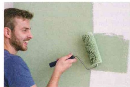
Die Kalkbuntfarben von Auro sind emissionsfrei, feuchtigkeitsregulierend und dank des hohen pH-Werts auch schimmelhemmend. Foto: Auro
