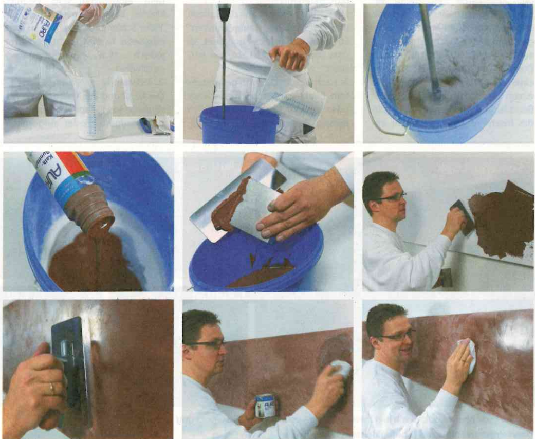
Glattspachteltechnik für Selbster: Man erzielt eine hochverdichtete Oberfläche, die sich seidenglatt anfühlt. Durch den Auftrag von Wandlasur-Wachs wird die Wand feuchtigkeitsabweisend. www.auro.de
