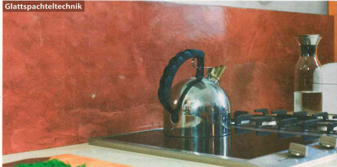
Glattspachteltechnik für Selbster: Man erzielt eine hochverdichtete Oberfläche, die sich seidenglatt anfühlt. Durch den Auftrag von Wandlasur-Wachs wird die Wand feuchtigkeitsabweisend. www.auro.de
