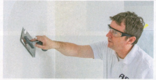
Glattspachteltechnik mit Profikalkspachtel von Auro. Das Material wird nach Vorschrift mit Wasser angemischt. Es wird abschnittsweise mit der Kelle auf die Wand aufgezogen und verdichtet.
