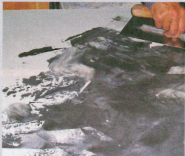
3 Material nachlegen und nass in nass weiter verteilen. Die Farbtöne vermischen sich während des Auftragens unterschiedlich.
