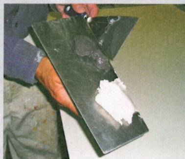
1 Je einen Klecks weiße und dunkle Spachtelmasse auf die Kelle geben und auf den zuvor abgespachtelten Untergrund geben.
