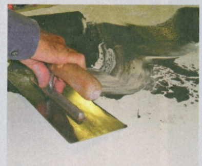
2 Das Material schwungvoll kreuz und quer auf die zu gestaltende Fläche auftragen. Immer nur in kleineren Abschnitten arbeiten.
