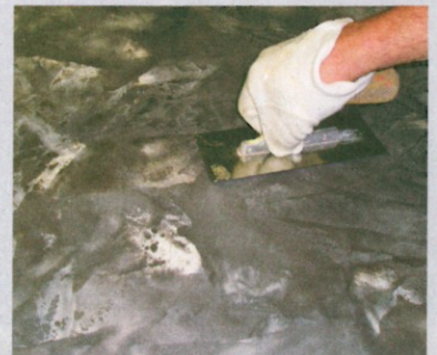
4 Mit Gefühl muss abgeschätzt werden, wie weit man die Farben vermischt, damit nicht zu viel von der kontrastreichen Textur verlorengeht.
