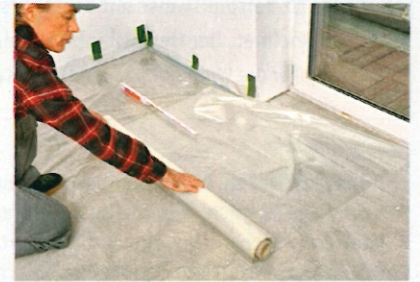
① Passende Unterlage auflegen, hier 0,2 mm PE-Folie. Im Stoßbereich Bahnen um 30 cm überlappen lassen.
