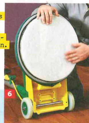
6 Mit einem feineren, weißen Pad die Fläche nun polieren.
