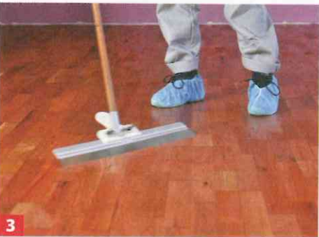
3 ... Stellen nachölen. Dann Überschuhe anziehen und überschüssiges Öl mit Raket abziehen bzw. mit Baumwolltuch aufnehmen.
