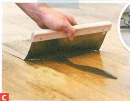
C Reste mit einem Raket aufnehmen. Dann ein weißes Pad aufspannen ...
