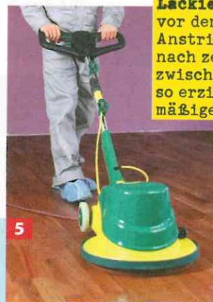
5 Das Öl wird damit in die Holzoberfläche eingearbeitet.
