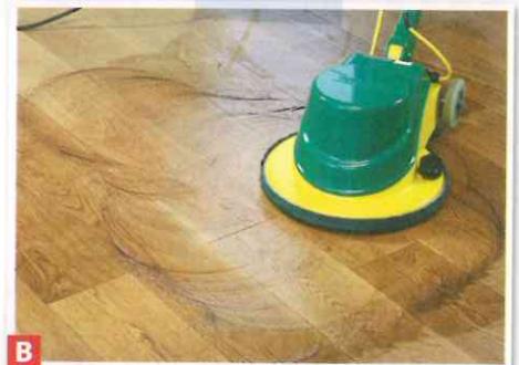
B Aufschütten und mit mittlerem Pad und Schleifmaschine den Schmutz anlösen.
