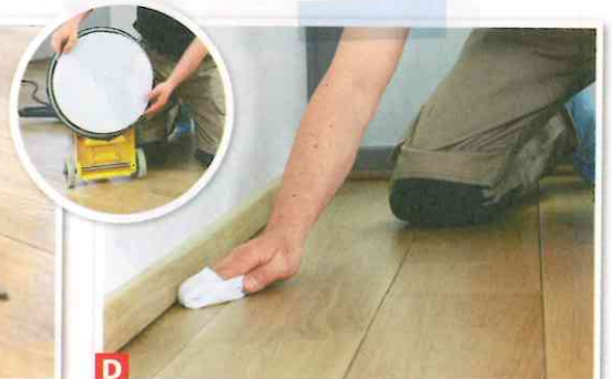
D ... und die Fläche nacharbeiten, Randbereiche mittels Tuch. Nun ggf. neu ölen.
