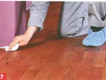
7 Die Randbereiche mit Baumwolltuch nachbearbeiten. Den Boden 24 Stunden trocknen lassen, dann ggf. Vorgang wiederholen.
