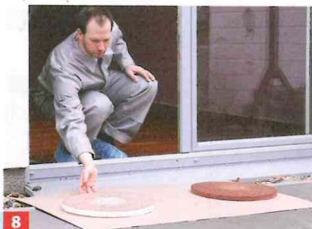
8 Je nach Ölhersteller benutzte Pads abnehmen und trocknen lassen oder aber in geschlossenen Behältern aufbewahren.*
