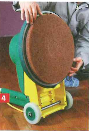
Innerhalb einer Einwirkzeit von 30 bis 60 Minuten folgt der erste „Poliergang“: Dazu den Teller-schleifer mit rotem/braunem Pad bestücken.
