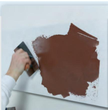
In schwunghaften Zügen arbeiten, bis Seidenglanz entsteht. Die optimale Schichtdicke ist max. 1 mm. In unserer Videoanleitung (siehe Rückseite) können Sie sich diesen Vorgang genauer anschauen. Die Wand 12 Stunden trocknen lassen.
