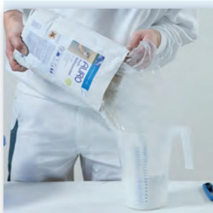
Die Bestimmung der richtigen Menge Spachtel-Pulver gelingt am besten mit einem Messbecher.
