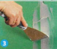
**1** Das 3,6-kg-Gebinde kostet etwa 27 Euro. **2** Erst Fugen und Hohlstellen füllen, **3** dann die Fläche bahnenweise verspachteln.
